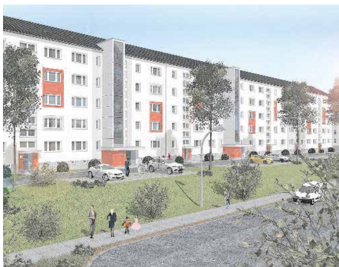
Eine umfangreiche Komplettsanierung ist auch an den Wohnhäusern Neefestraße 41 – 53 geplant. Abb.: Albert & Partner
