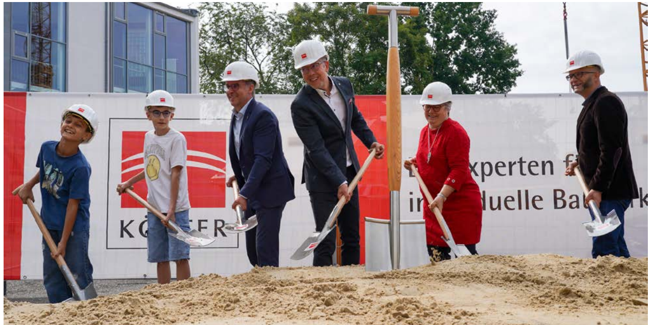
Mit dem ersten Spatenstich wurde der zweite von drei Bauabschnitten eingeläutet.
