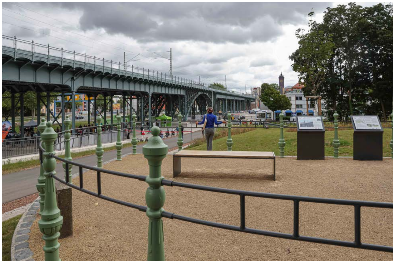
Mit einem Fest am Viadukt beginnt der Tag des offenen Denkmals bereits am Samstag.
