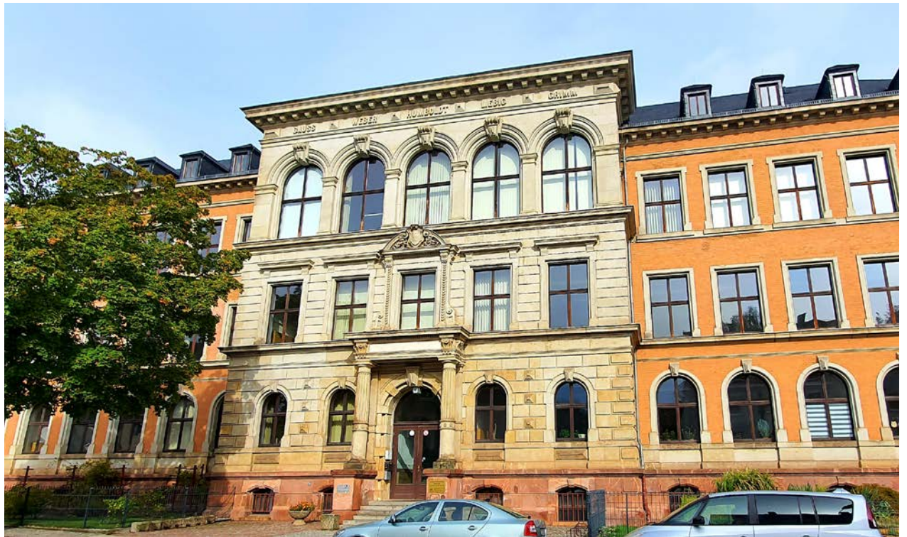
Das Gebäude Wielandstraße 4 soll in Zukunft für gymnasiale Bildung genutzt werden.
