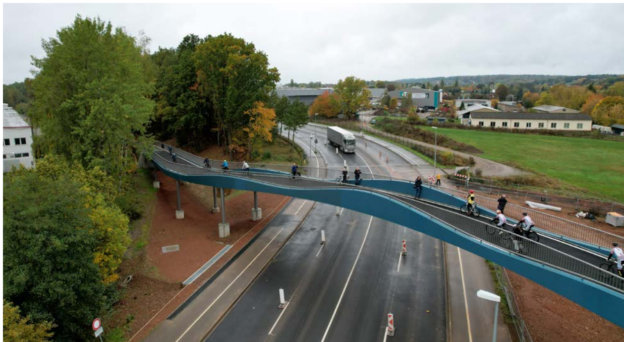
Die Brücke über die Kalkstraße ist nun für den Radverkehr freigegeben.
