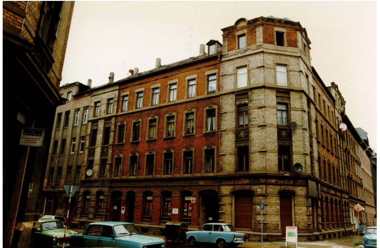
Zustand des Gebäudes um 1993, links die später abgerissene Philippstraße 19.
