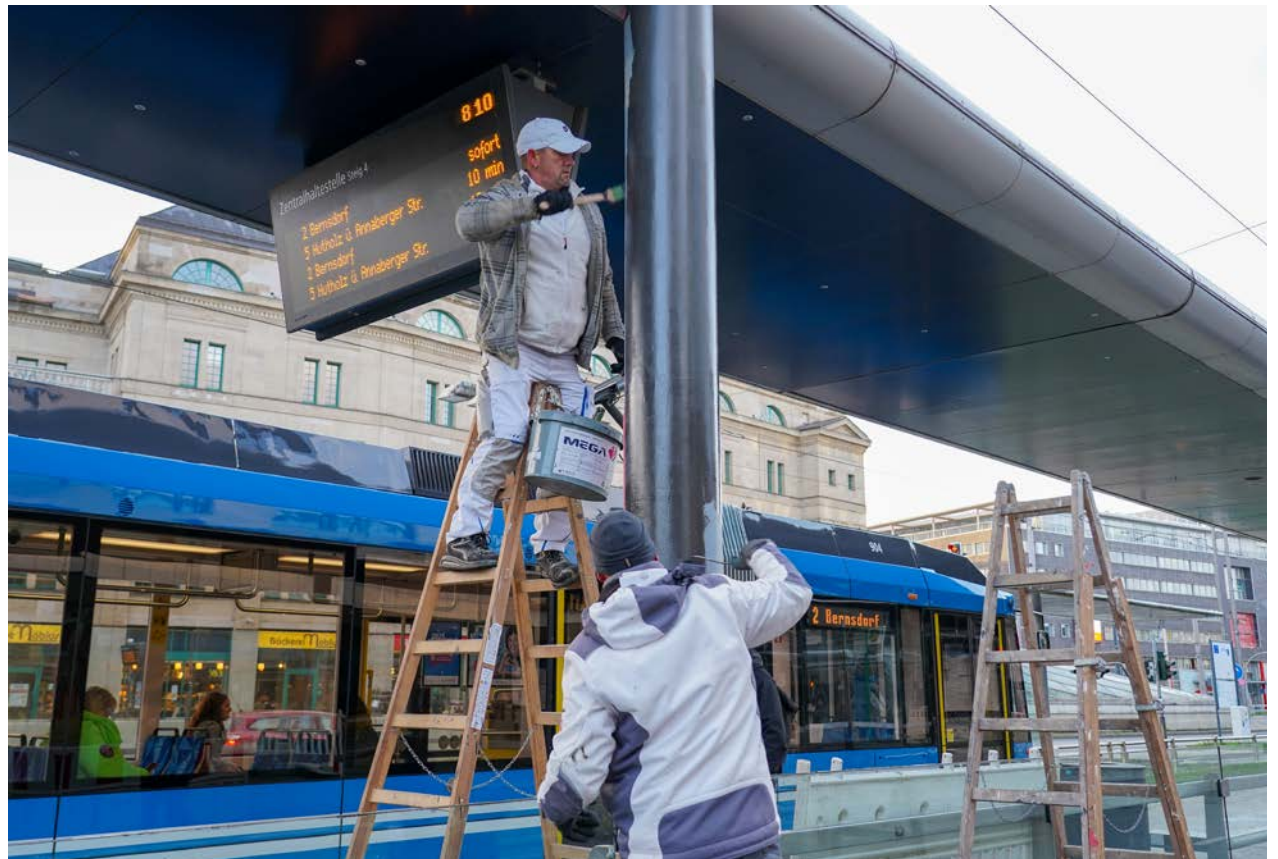
Die ersten Malerarbeiten für das Wegeleitsystem haben bereits in dieser Woche begonnen.
