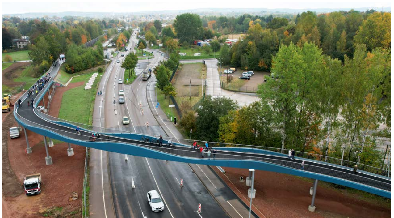
Seit die Radbrücke über die Kalkstraße fertiggestellt ist, nutzen mehr Radfahrende den Weg.
