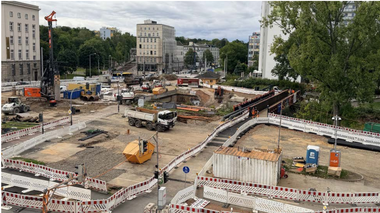
Die neue Brücke für den Fußgänger- und Radverkehr über die Chemnitz.
