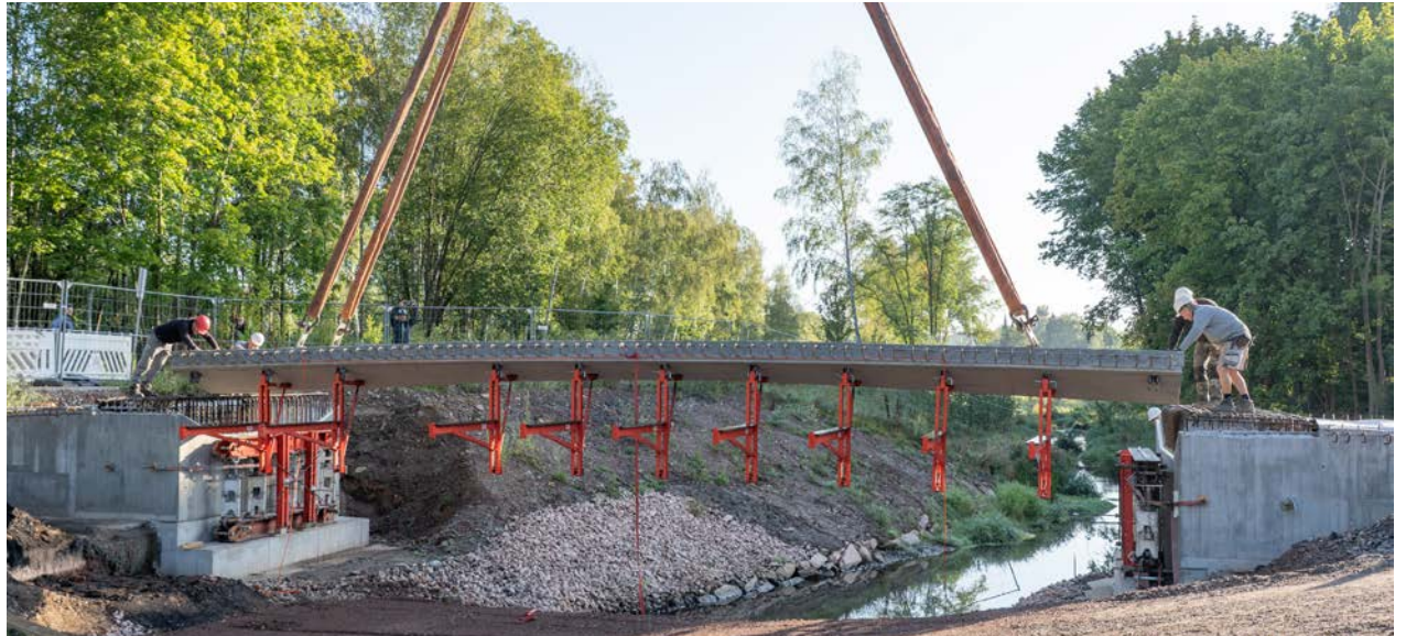
Am Dienstagmorgen wurde die 15 Meter lange Brücke über den Pleißebach eingehoben.
