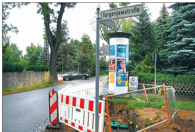
Ende August beginnen die Arbeiten an der Cervantesstraße im Abschnitt Adelsberg- bis Turgenjewstraße.
