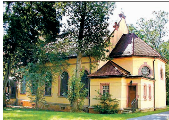
Die Kirche im Rehabilitationszentrum für Blinde und Sehbehinderte in der Flemingstraße 8 c. Hier gibt es zu Tag des offenen Denkmals eine Ausstellung mit Motiven Chemnitzer Sakralbauten in Aquarell zu sehen.
