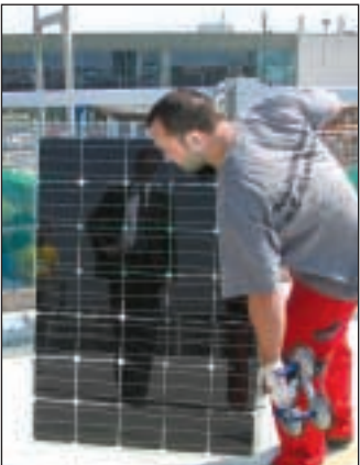
Steve Tollhupp bei der Montage des ersten Solarmoduls. Foto: Schmieder
