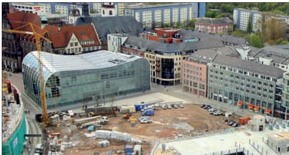
Bisher wurden rund 50 Millionen Euro in der Chemnitzer Innenstadt investiert. Jetzt folgt der Lückenschluss auf dem Baufeld 3. Foto: Sax
