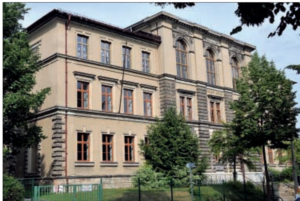
Schulsanierungen wie die der Schloss-Schule ist eine der vordringlichen Aufgaben der nächsten Jahre. Foto: Faust
