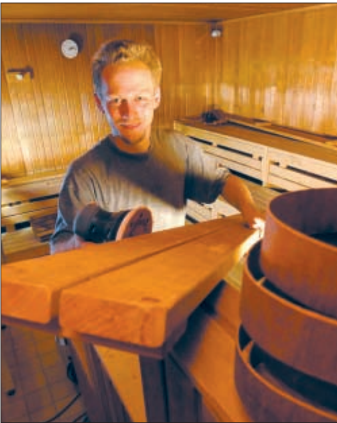
Derzeit werden die Saunen im Stadtbad auf Vordermann gebracht.
