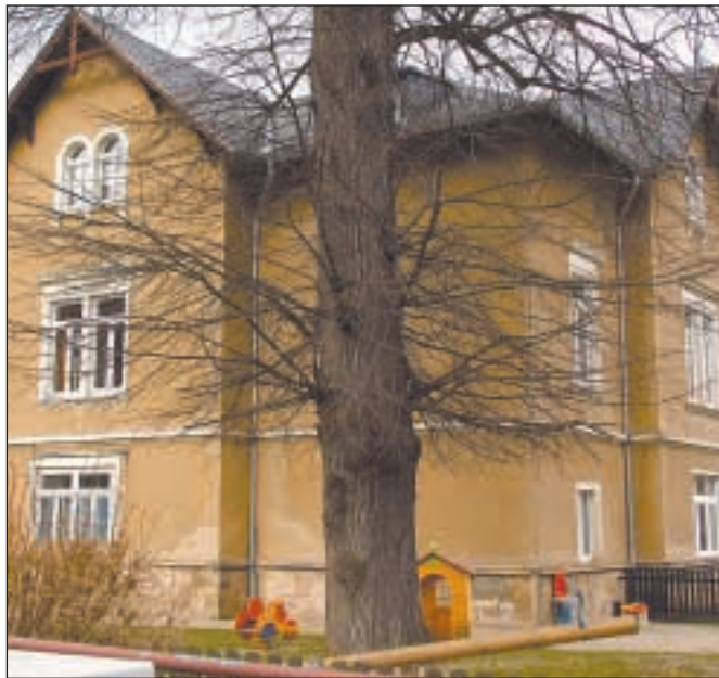
Die Fassade der Kita Einsiedler Straße wird saniert.
