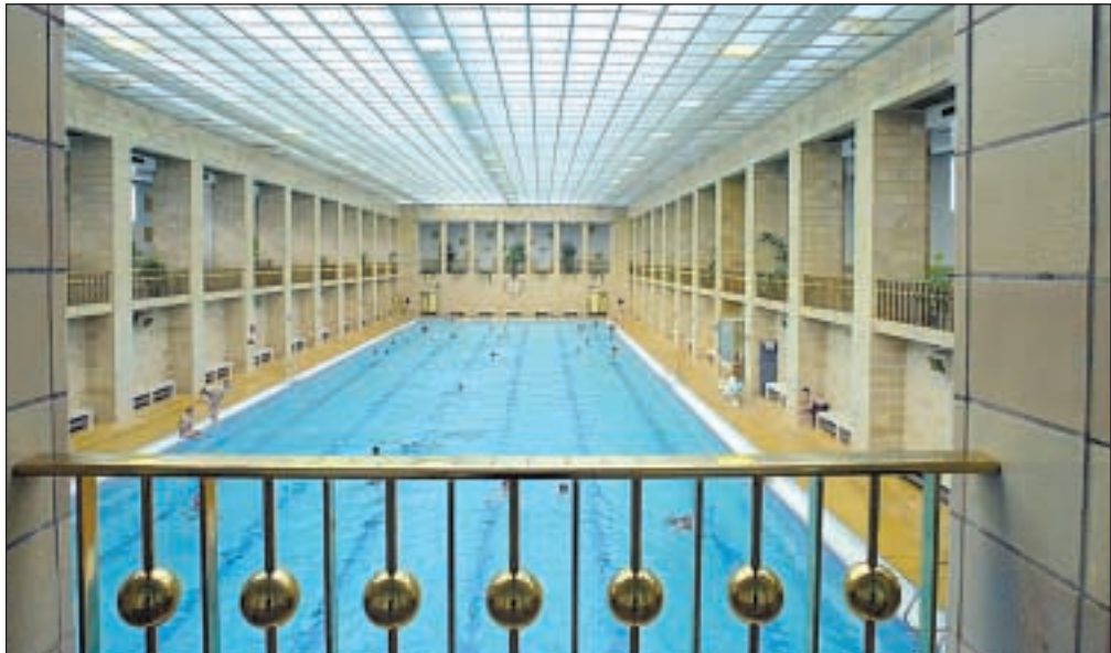
Das architektonisch bedeutende Stadtbad wird saniert. Über 250.000 Besucher treiben hier jährlich Sport und erholen sich.
