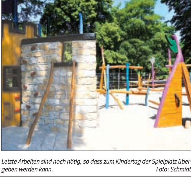
Letzte Arbeiten sind noch nötig, so dass zum Kindertag der Spielplatz übergeben werden kann. Foto: Schmidt
