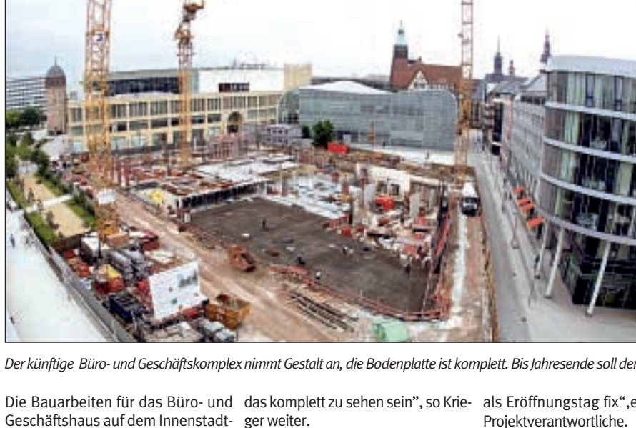
Der künftige Büro- und Geschäftskomplex nimmt Gestalt an, die Bodenplatte ist komplett. Bis Jahresende soll der Rohbau stehen.
