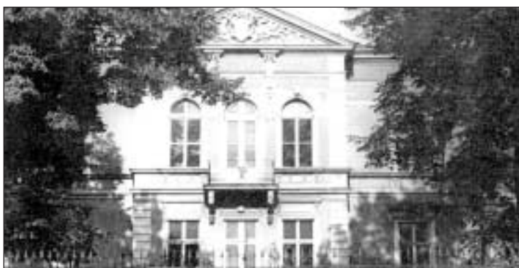
Das Wohnhaus Richard Hartmanns an der Kaßbergstraße. Das im klassizistischen Stil 1868 erbaute Gebäude wurde 1899 umgebaut.
