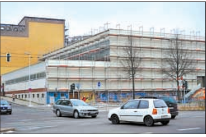
Derzeit eingerüstet: die Industrieschule
