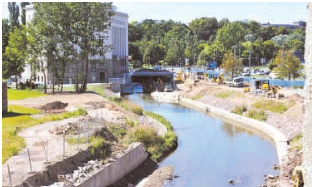
Sommer 2009: Die Chemnitz liegt frei. Noch verbergen blaue Bauzäune den Fluss vor den Blicken der Passanten. Inzwischen entstehen Stützmauern vis á vis der Deutschen Bank. Foto: Schmidt
