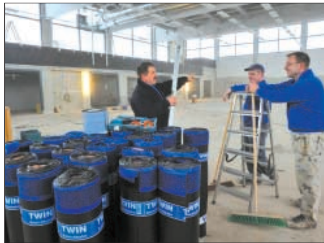
Im Sportgymnasium sind noch Leistungen am Estrich und der Haustechnik noch auszuführen. Foto: Schmidt
