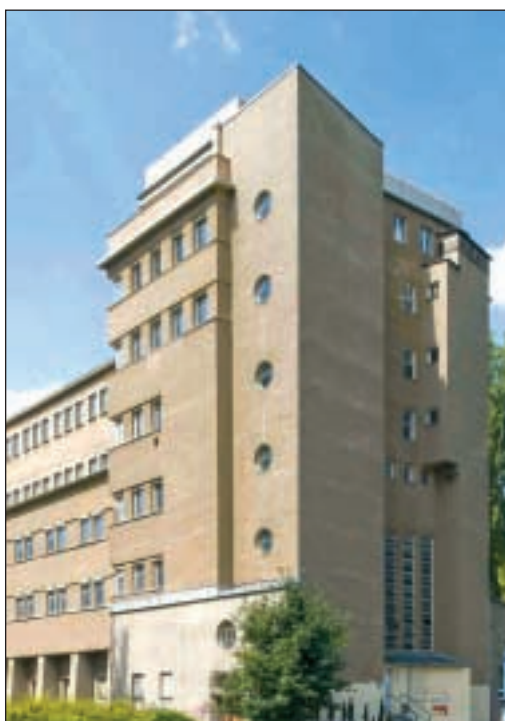
Markant: Der Poltrock-Bau außen und Bautätigkeit innen.
