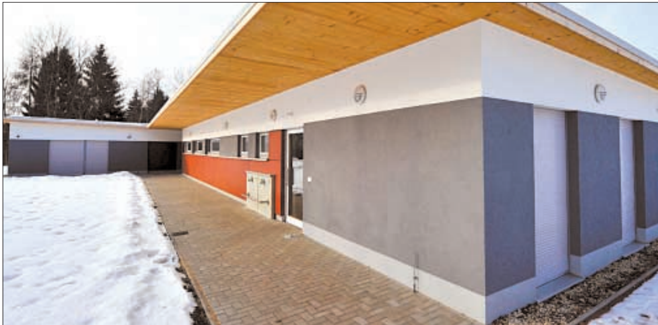
Endlich bezugsfertig: das neue Vereinsheim des TSV IFA Chemnitz an der Eubaer Straße.
