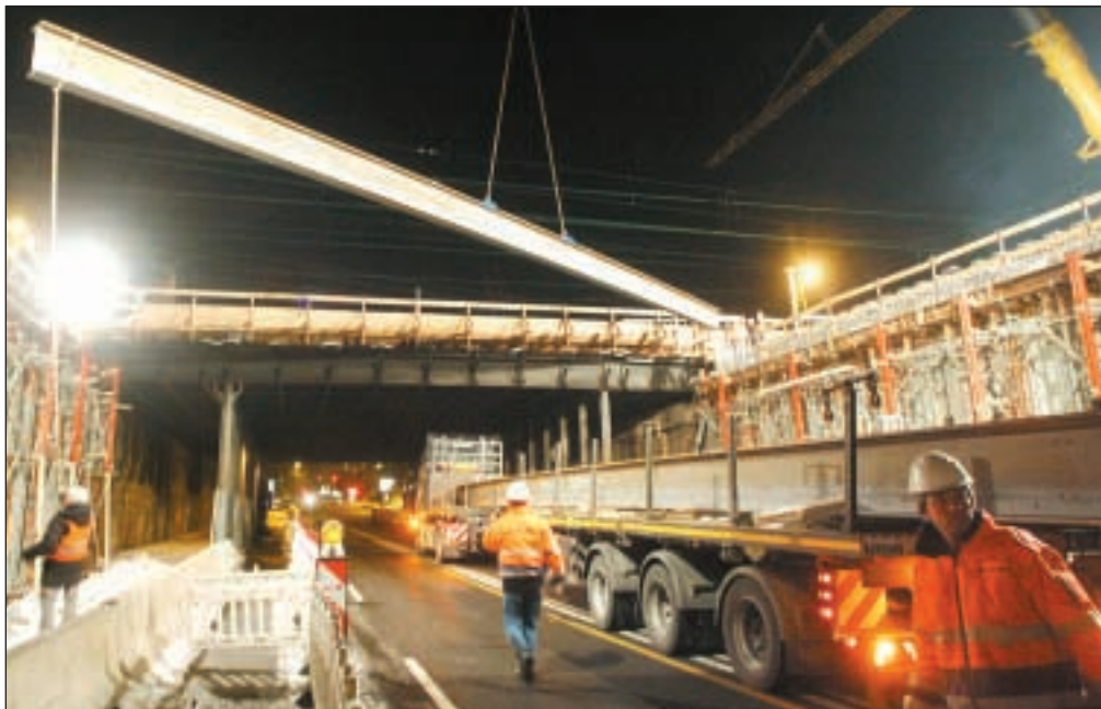
Zirka 5,5 Tonnen schwer und 21 Meter lang sind die Träger, die an der Eisenbahnbrücke August-Bebel-Straße montiert werden. Foto: Truxa
