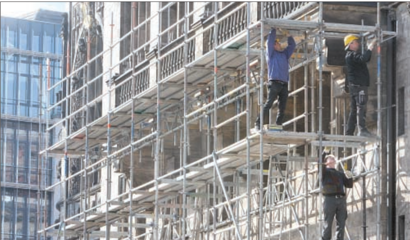
Derzeit wächst ein Gerüst an der Rathausfassade empor.
