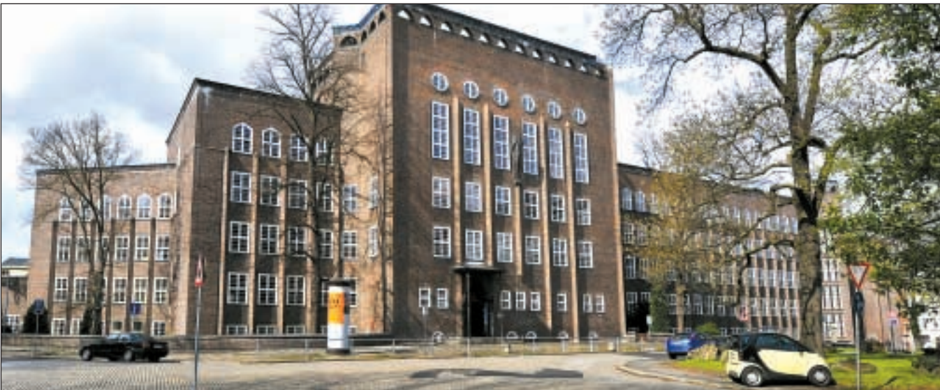
Der Stadtrat beschloss jetzt ein Sanierungskonzept für alle Schulen. Millionen Euro flossen bereits in die Rekonstruktionen einzelner Einrichtungen – so die der Industriesschule.
