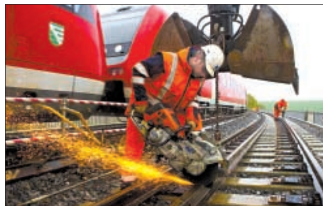
Umfassende Bauarbeiten am Chemnitzer Hauptbahnhof und darüber hinaus sind derzeit mit Einschränkungen für Reisende verbunden. Foto: Schmidt
