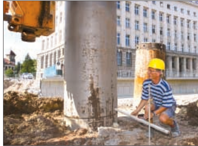
Derzeit entstehen Fundamente für die neue Brücke über die Chemnitz zwischen Aue und Bahnhofstraße.
