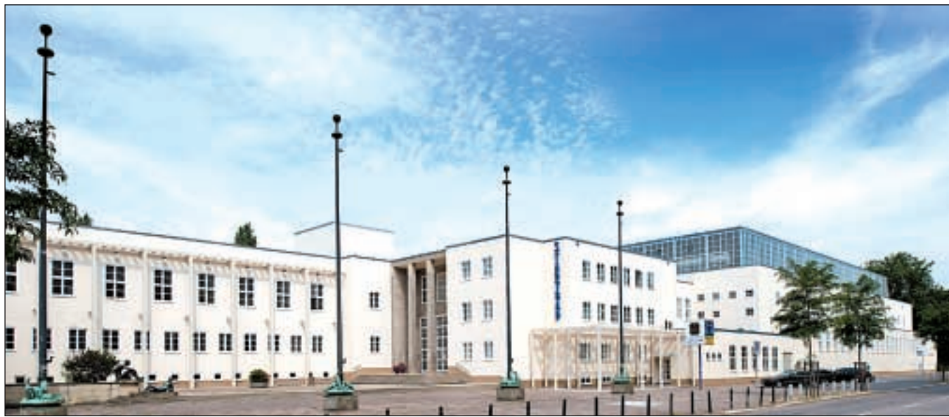
Das Panoramafoto zeigt nicht nur die erneuerte Fassade des Stadtbades, sondern macht auch dessen großzügige Dimensionen deutlich. Selbst dessen geistigem Vater, Stadtbaurat Fred Otto, nötigten diese Respekt ab: „Galt es doch mehr als 84.000 Kubikmeter umbauten Raumes und 7.000 Quadratmeter Grundfläche organisch zu formen“, formulierte er die Aufgabe.
