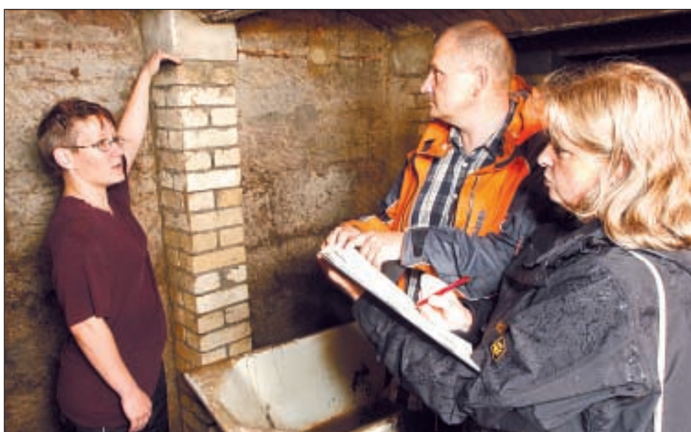
Der Stadtteil Harthau war besonders von der Überschwemmung betroffen. Kati Hofmann, Mieterin eines Hauses Am Harthauer Bahnhof zeigt Peter Wettke und Karin Wolny von der Stadt die Wasserhöhe im Keller. Die beiden Stadtmitarbeiter begutachten derzeit Schadensfälle von Betroffenen.
