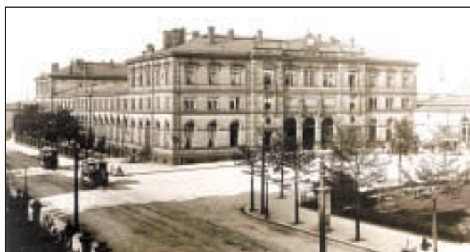
1852 gab es die erste Eisenbahnlinie Chemnitz – Riesa. 1854 errichtete man das Vorgänger-Gebäude des heutigen Hauptbahnhofes. Der Hauptbahnhof in seiner heutigen Gestalt entstand 1872.
