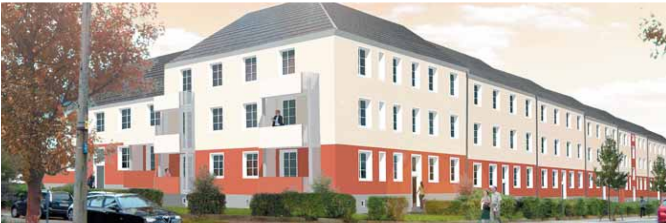
Zum Programm der Wohnungsgesellschaft 2011 gehören die Rekonstruktionen von Häusern entlang der Münchner Straße und des »Charlottenhofes« (hier in unserer Abb.). Abb.: GGG
