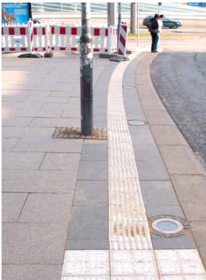
In Chemnitz entwickelt von der Firma Railbeton wurden neuartige Knisterplatten, die Sehbehinderte sicher im Verkehr leiten. Foto: Railbeton
