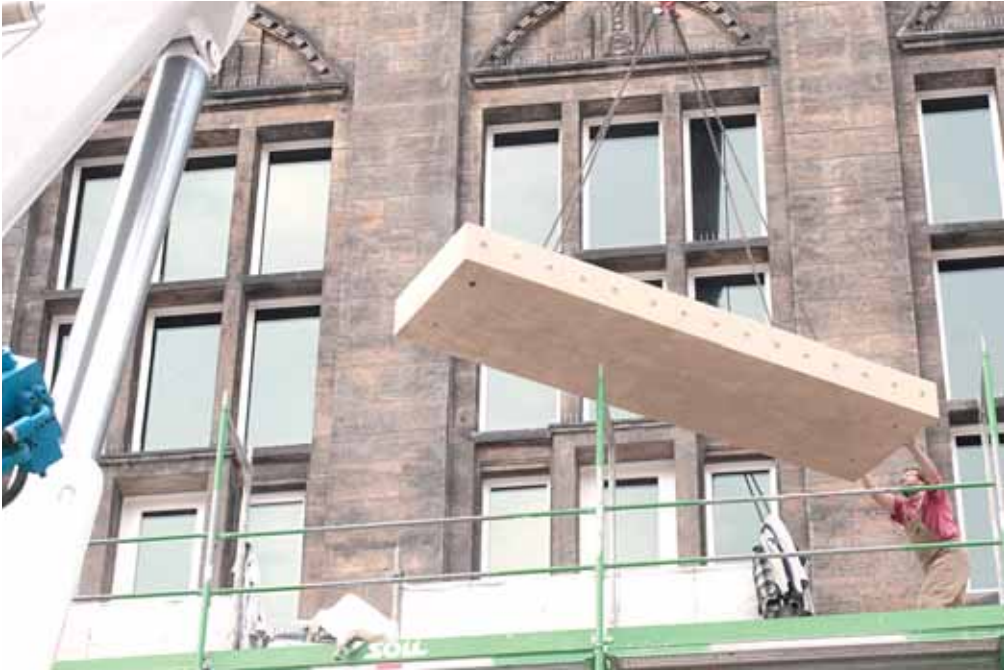
Stück für Stück wurden die Betonteile von einem Kran wieder am Balkon des Stadtverordnetensaales angebracht. Die originalgetreue Sanierung des Balkons kostete 67.000 Euro, insgesamt wurden 1,94 Millionen ins Neue Rathaus investiert, ein Großteil davon aus Mitteln des Konjunkturpakets II. Foto: Andreas Truxa
