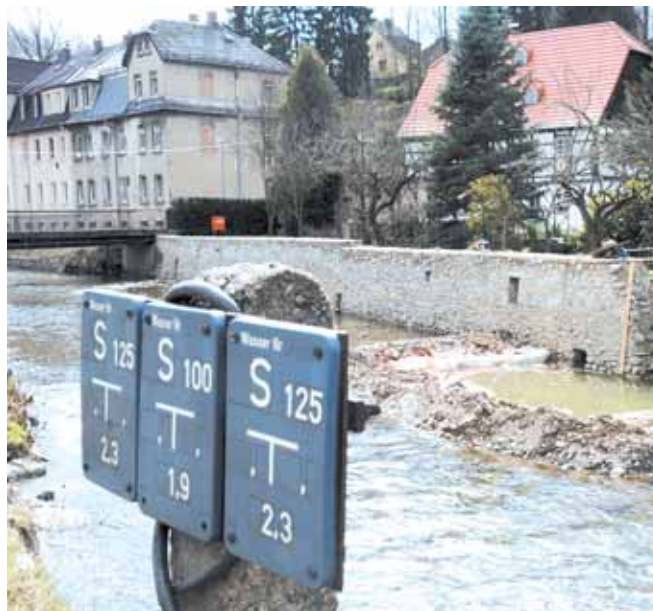
Mit rund 15 Millionen Euro will das Land den Hochwasserschutz an der Zwönitz in Erfenschlag und Einsiedel verbessern. Foto: Wolfgang Schmidt
