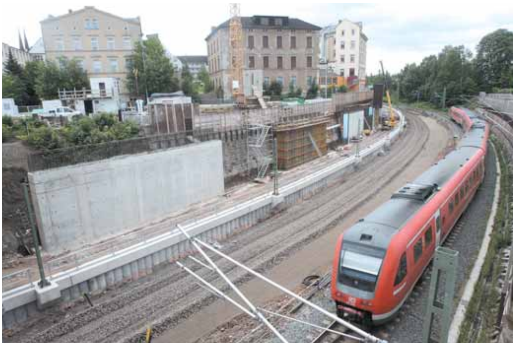
Eines der aktuell bedeutendsten Verkehrsbau-Vorhaben der Stadt wird mit dem Brückenneubau am Dresdner Platz in den kommenden Wochen fortgesetzt. Foto: Andreas Truxa
