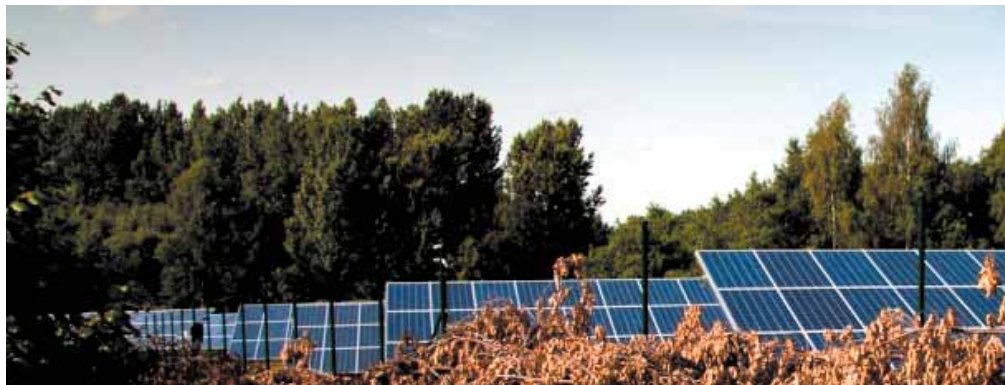
Der neue Solarpark am Südring geht in diesen Tagen ans Netz.
