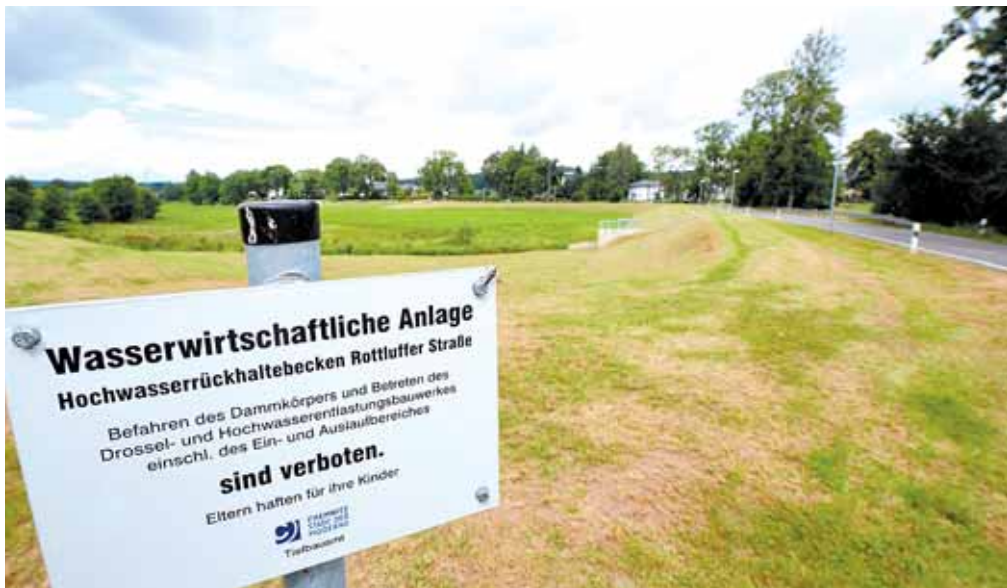
Dieses Regenrückhaltebecken ist in Rottluff im Jahr 2010 entstanden und kann im Notfall 40.000 Kubikmeter Wasser vom Rabensteiner Bach und dem Pleißenbach aufnehmen. Foto: Sven Gleisberg
