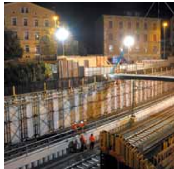
Großbaustelle Dresden Platz: Hier wurden im Oktober erste Brückenteile – jedes 20 Tonnen schwer – eingehoben. Am Dresden Platz läuft das derzeit größte Brückenbauvorhaben der Stadt. Foto: Andreas Seidel
