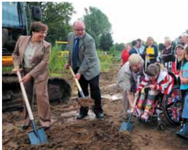
Kämmerer Berthold Brehm und Staatsministerin Brunhild Kurth setzten den ersten Spatenstich. In den nächsten Monaten erfolgen an der Heinrich-Schütz-Straße Gründungsarbeiten, so dass ab März der Rohbau für das Sonderpädagogische Förderzentrum entstehen kann. Foto: Sven Gleisberg
