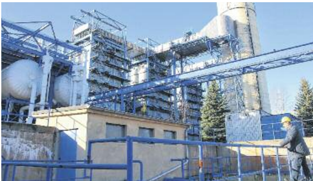
Im Juni beginnen die Rückbauarbeiten im Heizwerk Altchemnitz. Danach werden neue mit Erdgas betriebene Heißwassererzeuger errichtet. Foto: U. Dominik/einsenergie in sachsen
