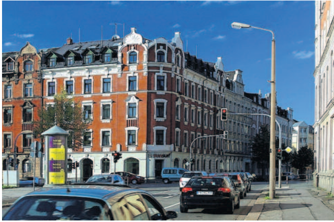
Verbesserten Fernwärmeanschluss gibt es bald auf dem Sonnenberg. Foto: Stadt Chemnitz
