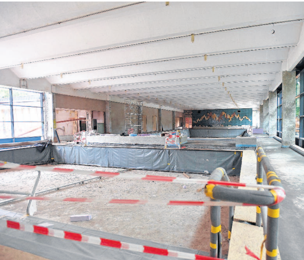
Ein Blick hinter die Bauplanen in der Schwimmhalle Gablenz zeigt den Fortgang der Sanierungsarbeiten. Foto: Wolfgang Schmidt
