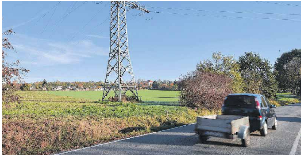
Der Neubau einer Zufahrt über die Glösaer Straße zur Erstaufnahmeeinrichtung für Asylbewerber steht an. Insgesamt werden 890 Meter Straße neu geschaffen und rund 200 Meter der Glösaer Straße umgebaut. Foto: Andreas Seidel
