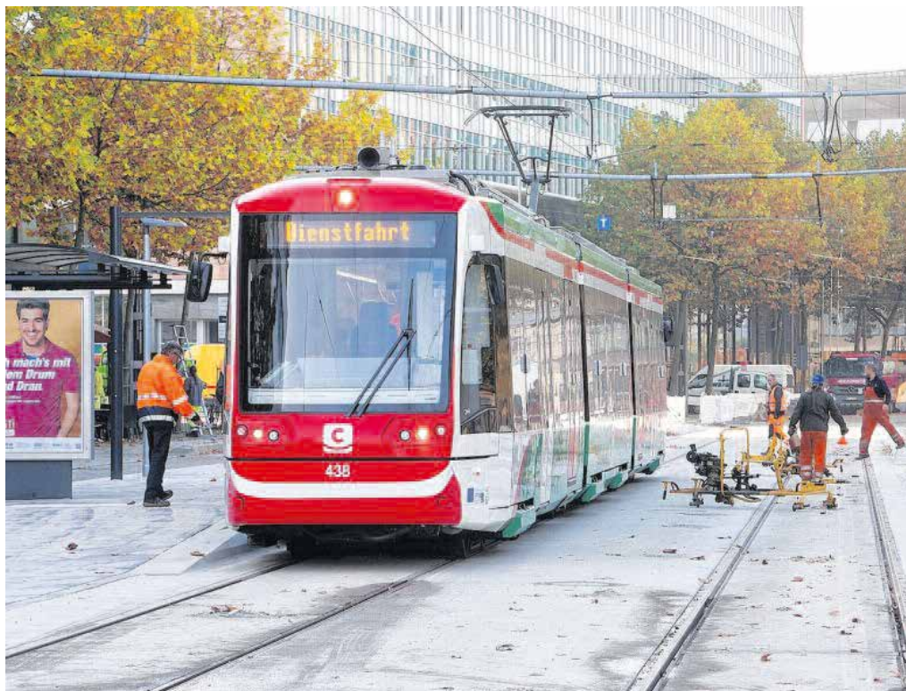
Ab November steuern Busse und Bahnen die umgebaute Haltestelle Roter Turm an. Kürzlich hatten Bahnen des VMS und der CVAG Testfahrten auf dem umgebauten Streckenabschnitt vorgenommen. Foto: Peter Zschage
