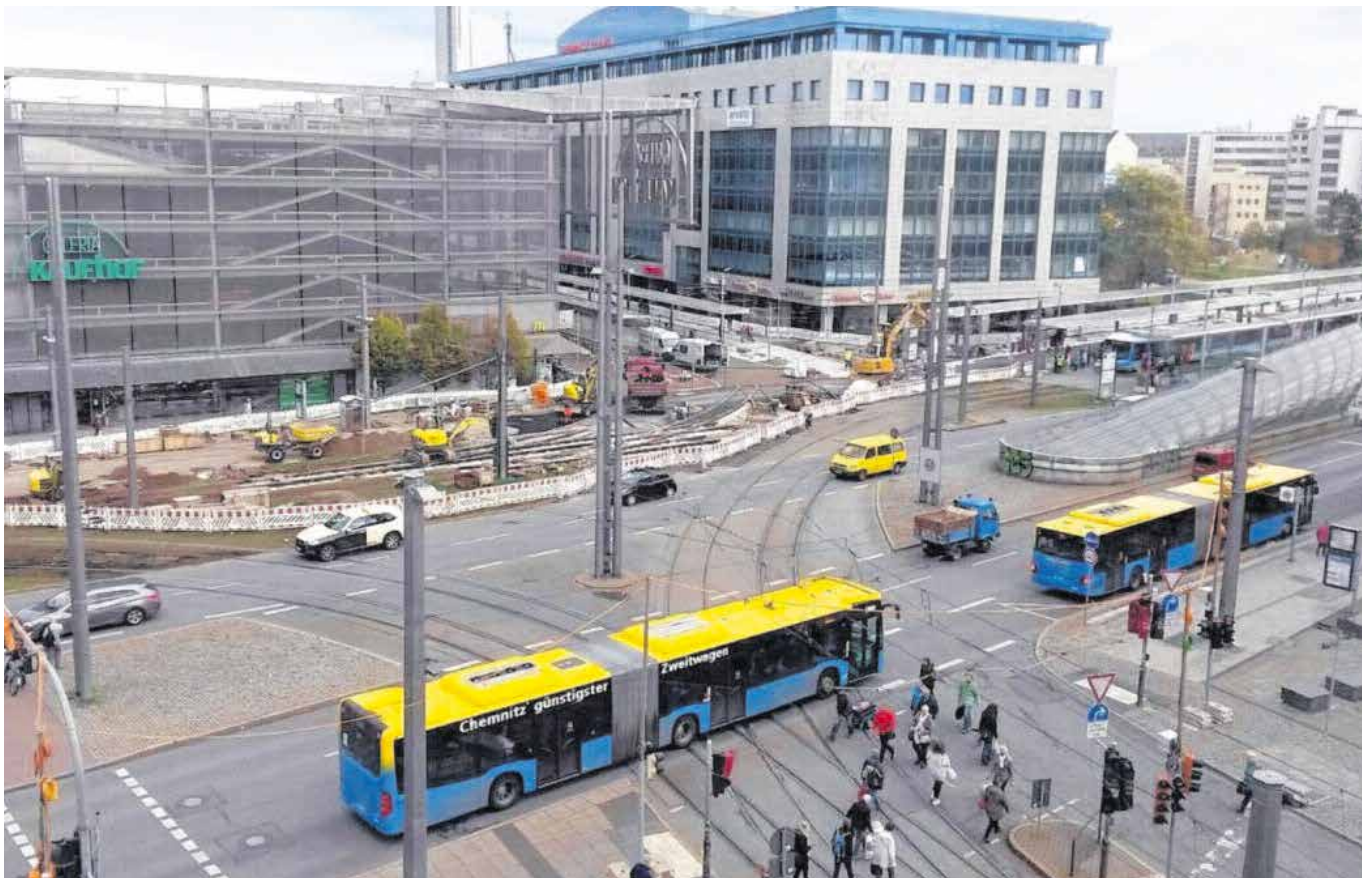
Die CVAG wird in den kommenden Monaten das Gleiskreuz Bahnhofstraße ausbauen lassen. Dadurch soll sich die Fahrzeit von Stadtbahnen zwischen Bernsdorf und dem Hauptbahnhof deutlich verkürzen. Foto: VMS
