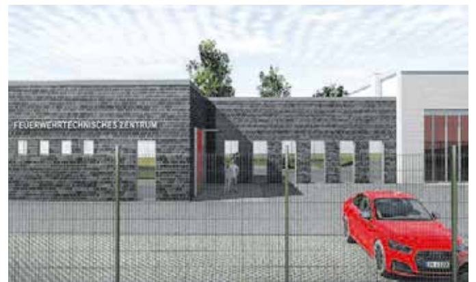
Ende 2019 wird das Feuerwehrtechnische Zentrum für Schulungs-, Ausbildungs- und Übungszwecke zur Verfügung stehen. Abb.1
