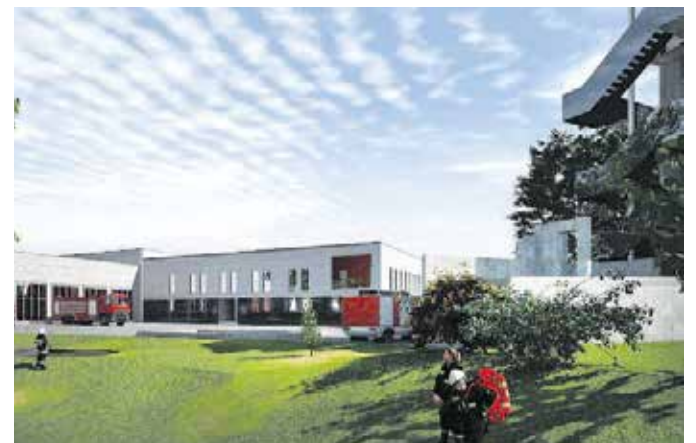
Das Gelände umfasst Übungsflächen für die Löschwasserentnahme, die Rettung von Verschütteten und die Bergung von Personen aus einer Straßebahn oder brennenden PKW und einen Übungsturm mit Keller. Abb.3
