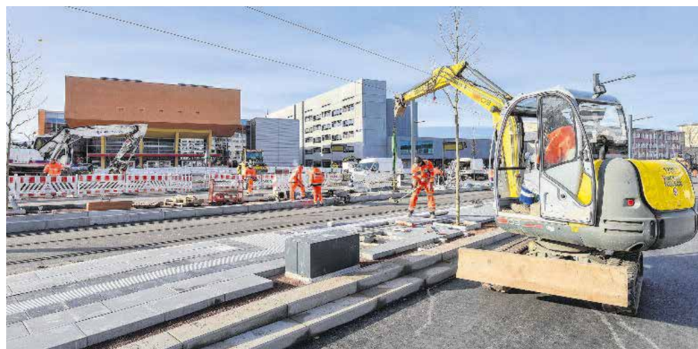
Noch sind die Baufirmen bei der Arbeit: Am 8. Dezember, 11 Uhr wird die neu gebaute Gleistrasse für die Straßenbahnlinie 3 und die Linien C13, C14 und C15 offiziell am gleichfalls neu gestalteten Campusplatz an der Reichenhainer Straße in Betrieb genommen. Foto: Kristin Schmidt
