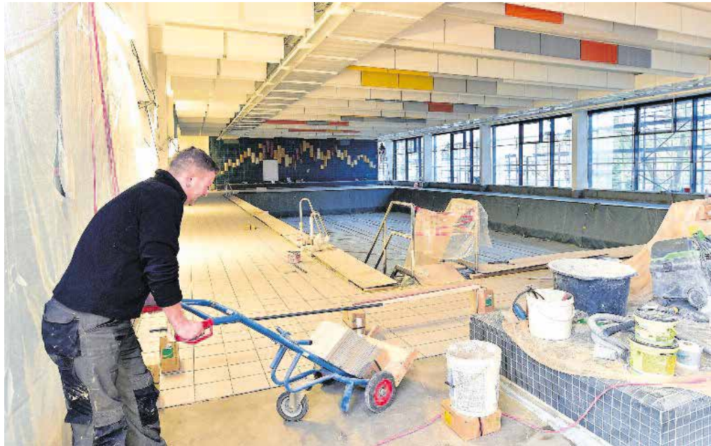
Derzeit wird in der Schwimmhalle Gablenz gefliest. Die Sanierung des Hallenbades sollte Ende 2017 abgeschlossen sein. Durch Verzug im Baugeschehen kann das modernisierte Hallenbad nun erst Anfang April 2018 wieder öffnen. Foto: Sven Gleisberg
