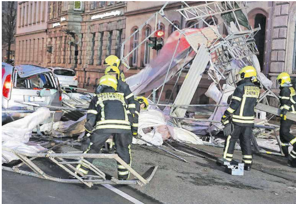
Ein Baugerüst in der Theaterstraße hielt den Orkanböen nicht stand und stürzte auf die Fahrbahn, dabei wurden acht Fahrzeuge beschädigt. Menschen kamen in Chemnitz nicht zu Schaden. Foto: Harry Härtel
