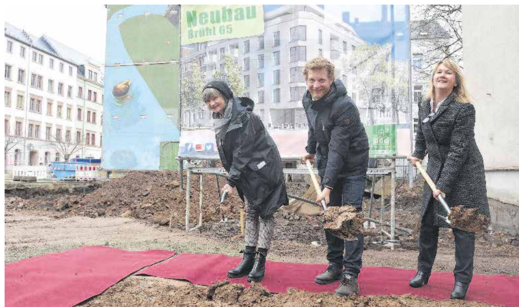
Am Mittwoch haben Oberbürgermeisterin Barbara Ludwig, Baubürgermeister Michael Stötzer und GGG-Geschäftsführerin Simone Kalew den symbolischen Spatenstich für ein Modellvorhaben am Brühl 65 vollzogen. Foto: Andreas Seidel
