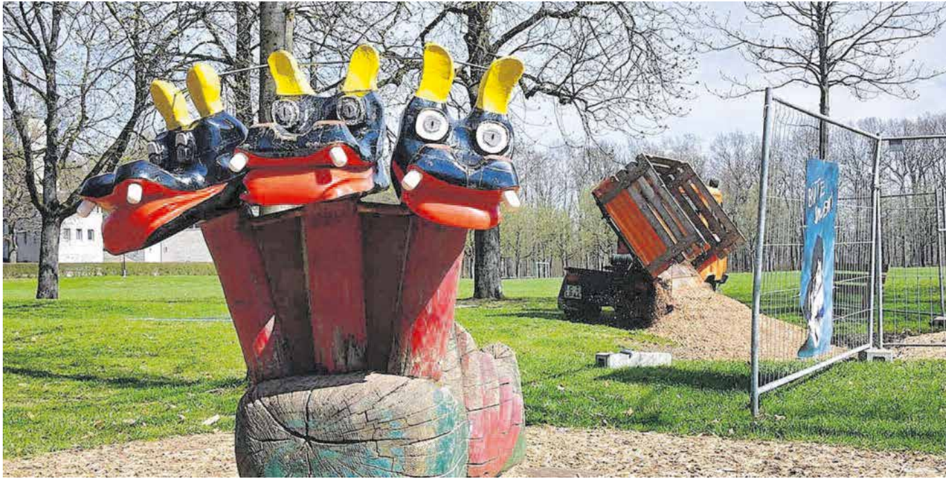
Der Küchwaldpark soll noch anziehender für Familien werden. Die Stadt hat jetzt mit den Arbeiten für eine Spielmeile dort begonnen. Foto: W. Schmidt
