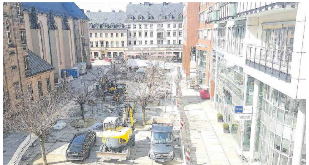
Noch bis Ende April dauern am Jakobikirchplatz die Arbeiten am Fontänenfeld.
