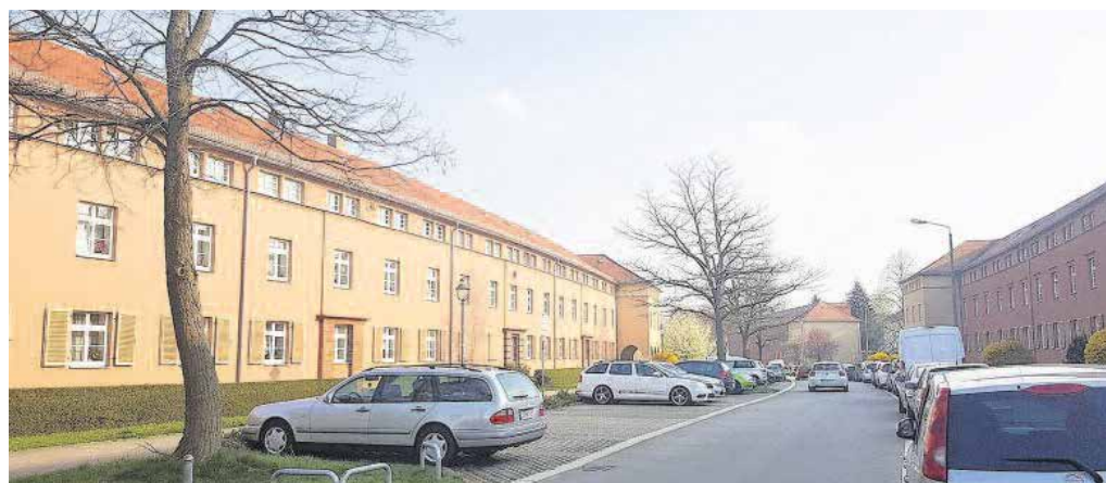
Die Gartenstadt in Gablenz wurde zwischen 1999 und 2003 denkmalschutzgerecht saniert. Foto: Monika Ehrenberg
