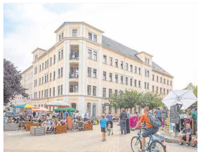
Am Brühl lässt sich beispielhaft der Nutzen von Städtebauförderung nachvollziehen. Wie hier am Brühl 51 wurden inzwischen von der GGG zahlreiche Gebäudesanierungen abgeschlossen. Auch private Eigentümer profitieren von Städtebaufördermitteln.
